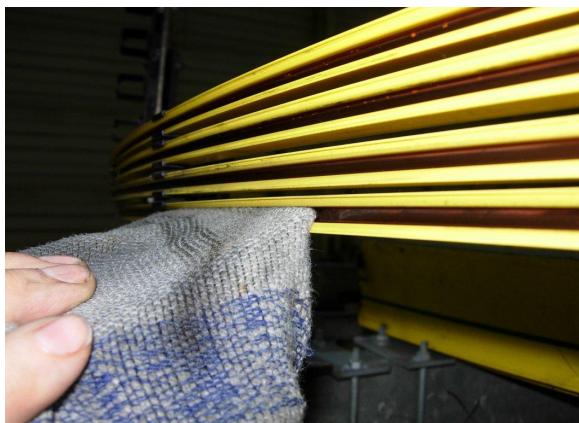
Ilustracja 10: Zmiana kąta narzędzia do czyszczenia w celu wyczyszczenia różnych obszarów
